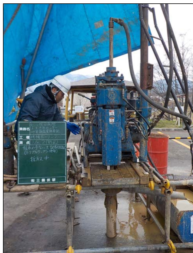
乱れの少ない土試料採取 (トリプルサンプラー使用)採取中
